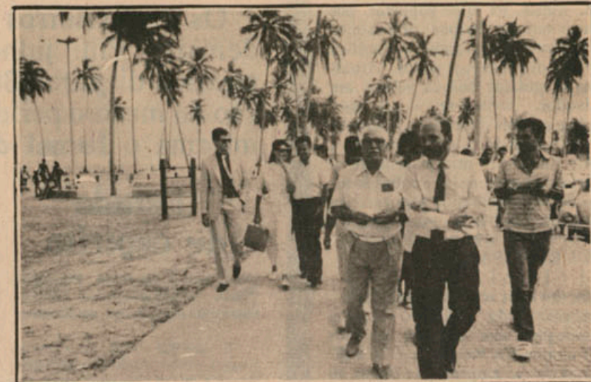
Dorival Caymmi visitou ontem as obras do Projeto da Orla
