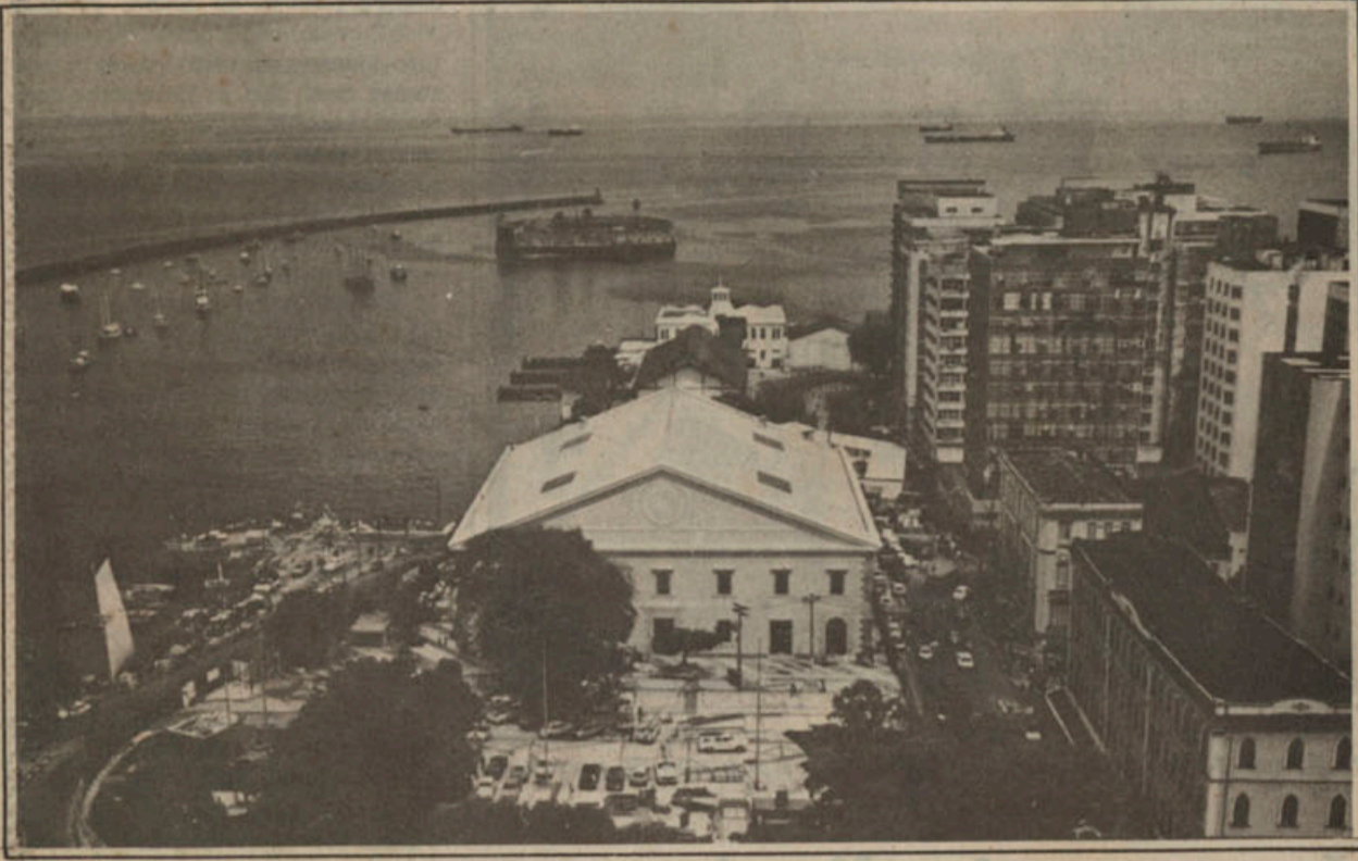
Mercado Modelo, reconstruído em tempo recorde e agora protegido contra incêndio
